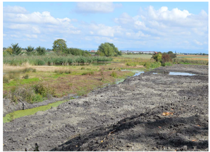
Travaux finis septembre 2017 ©M Cubizolle-LPO Auvergne
